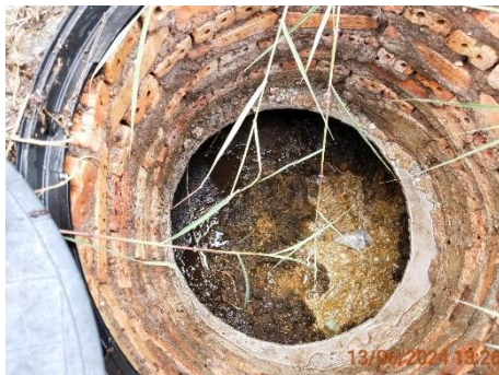
บ่อกักน้ำก่อนเข้าสู่ระบบบำบัดน้ำเสีย ชุดที่ 1 (ด้านทิศตะวันออก)
