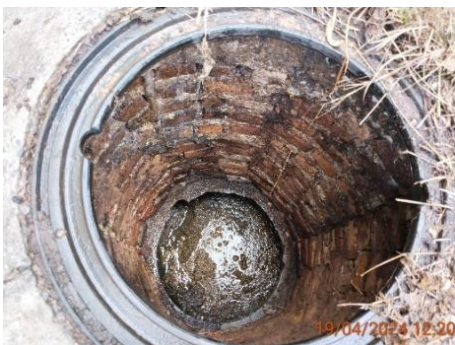
บ่อบำบัดน้ำก่อนเข้าสู่ระบบบำบัดน้ำเสีย ชุดที่ 3 (อาคาร A)
